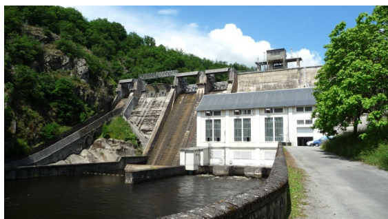
Barrage Saint-Marc à St-Martin-Terressus
