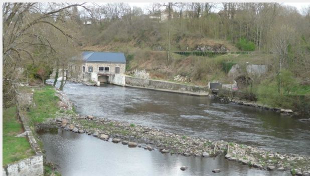
Micro centrale à Condat-sur-Vienne
