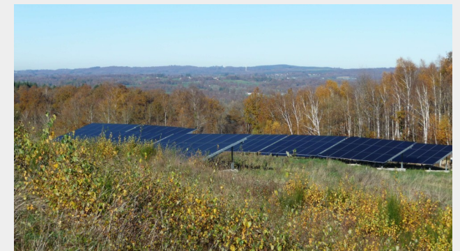
Parc photovoltaïque à St-Yrieix-La Perche
